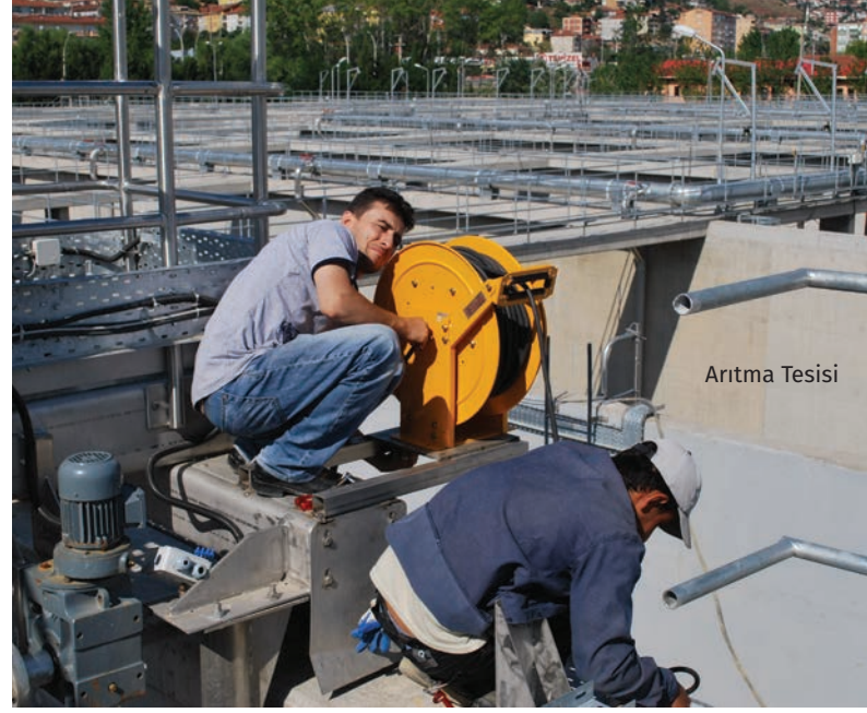
Vinçlerde Kullanılan Yağ ve Enerji Aktarım Tamburu
